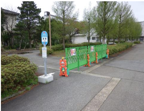
交通事故防止 スクールバスおよび豊浦地域コミュニティバスの停留所にフェンスを設置。現場事務所への出入り車両との交通事故を防止した。
