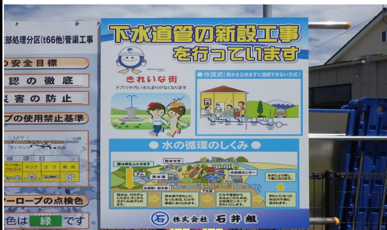
工事看板(水循環のしくみ)
