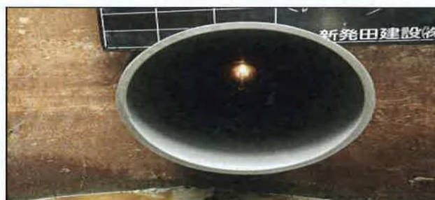
下水道管の埋設状況
