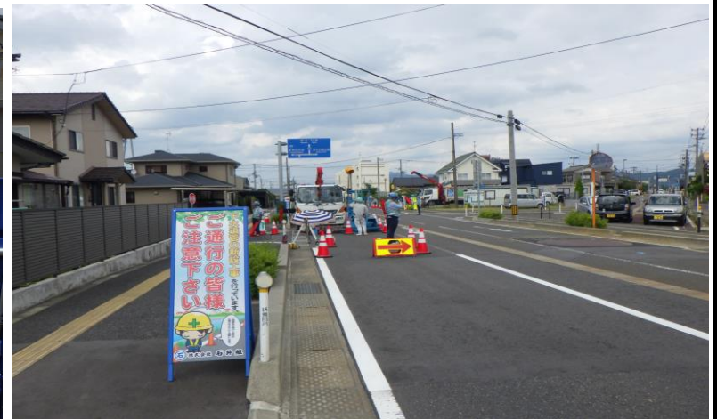
一般車両誘導状況
