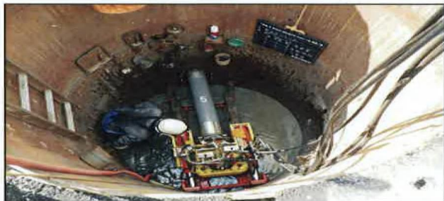
下水道管の開削工法による作業状況
