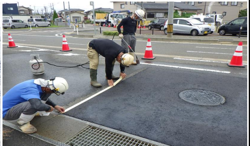
新旧舗装打継目養生
