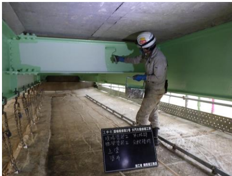
橋梁塗装工 桁の上塗塗布状況。河川の制約を踏まえ作業環境も考慮し、河川管理者との仮設工の変更協議を円滑に進めた。
