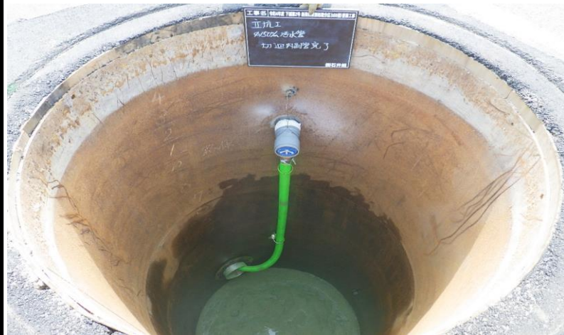
下水道接続仮廻し配管
