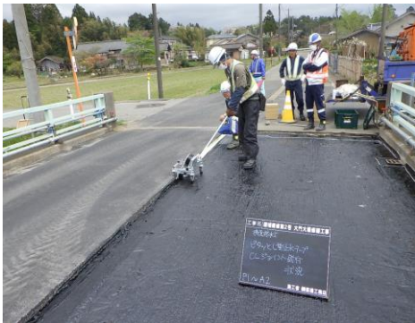
橋面防水工 L型の止水材(NETIS登録)を活用することにより設置後の剥がれを防止し、橋面舗装センターのコールドジョイントからの浸水対策を行った。
