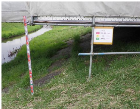
作業環境の改善 雪解けによる河川水位の増水を目視できるよう水位標を設置。
