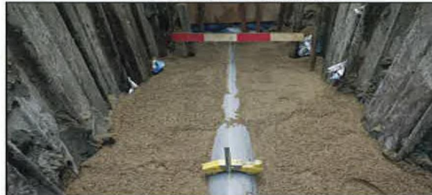
下水道管の埋設状況
