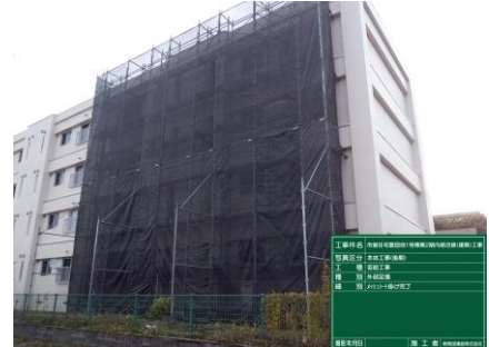
外部足場施工状況
