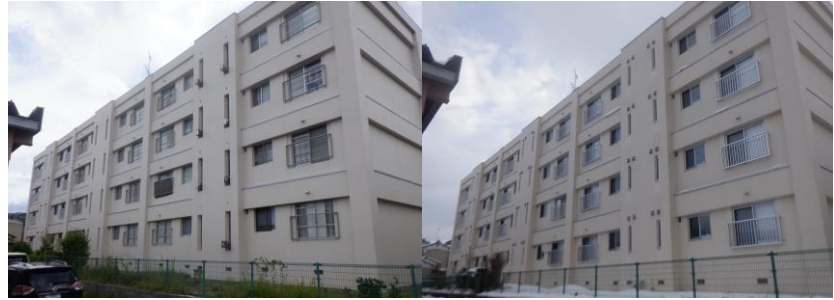
外部着手前 外部施工完了
