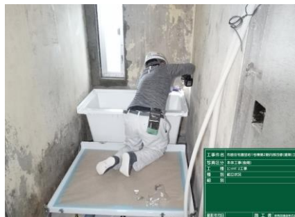
ユニットバス施工状況
