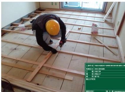
既存床嵩上げ状況
