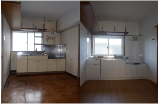
内部着手前 内部施工完了
