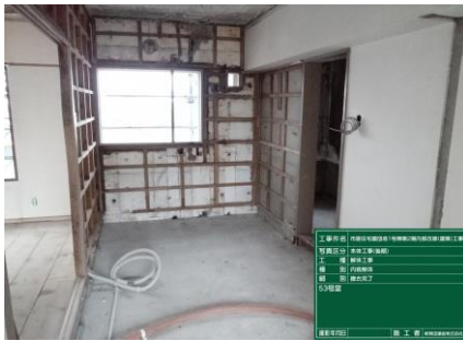
解体撤去完了(床、壁、天井撤去)
