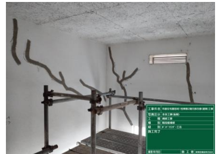
階段室劣化部補修状況
