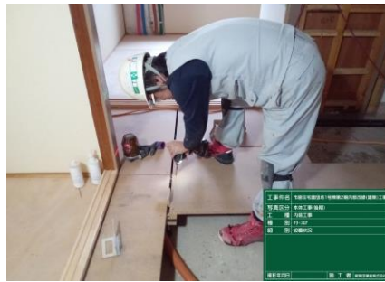
二重床施工状況
