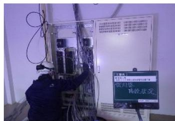
施設管理を簡素化できるように既存外灯の回路にソーラータIMERを組み込み、自動点灯出来るよう施工を行った。
