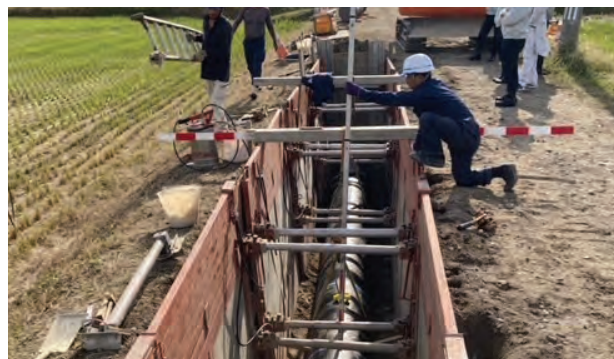
基幹管路の耐震化工事
