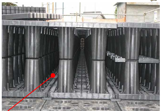
イメージ写真 (ブロック内部)
