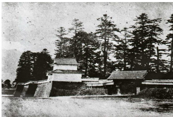
解体前の土橋門（右）と鉄炮櫓（左） （明治5～7年頃撮影、市歴史図書館蔵）
