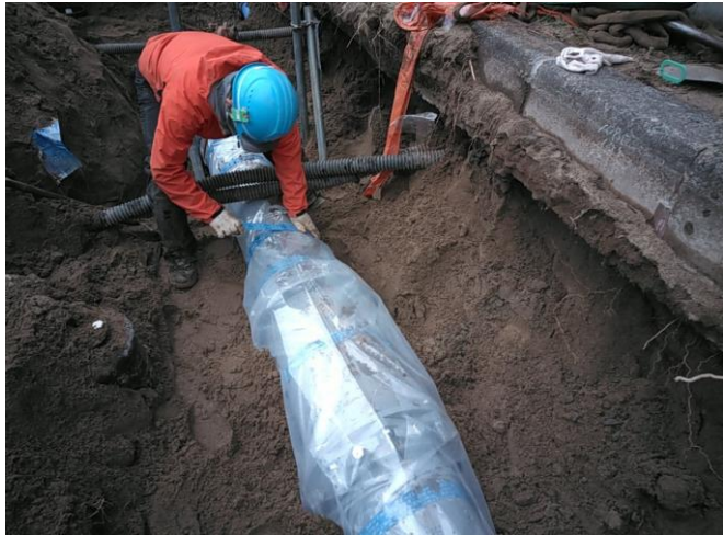
異種金属(鋳鉄管・ステンレス管)による電食防止措置
