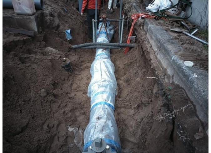
異種金属(鋳鉄管・ステンレス管)による電食防止措置
