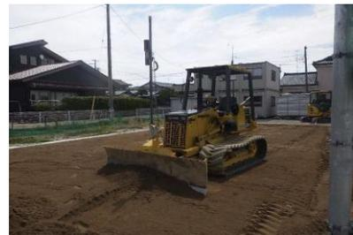
マシンコントロールセンサーブルドーザーを用いた土系舗装工の施工を実施し施工期間の大幅な短縮を行った。
