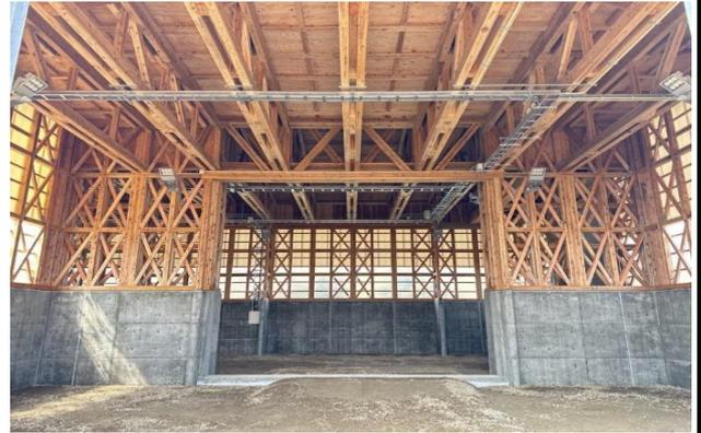
BCJ評定取得のワイヤー工法によるB種耐震施工
