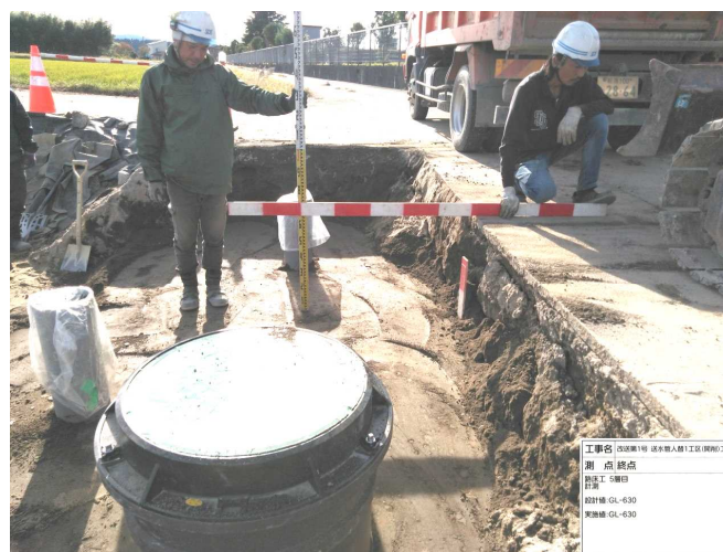
基幹管路の工事の様子
