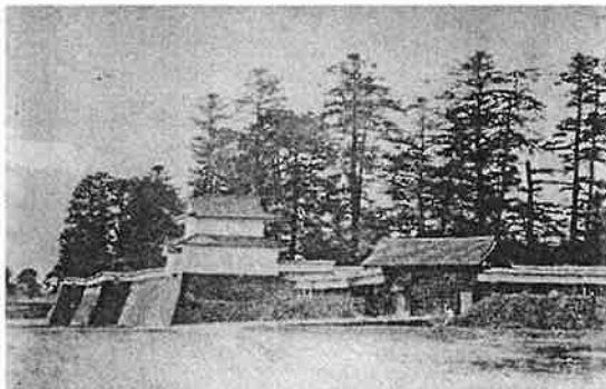
▲鉄砲櫓・土橋門（明治 7 年以前）
