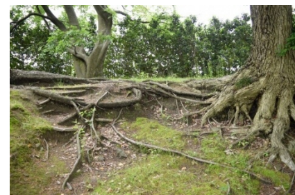
写真 5-3 エロージョンによる 土塁の表面破損状況
