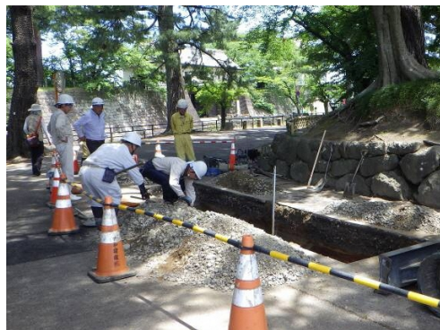
写真 5-11 2 トレンチ（東西）調査状況（南西から）
