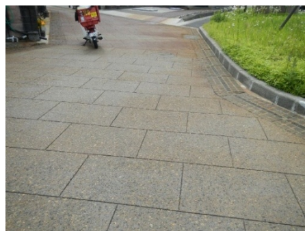
写真 6-8 石畳風舗装の事例② (長岡市摂田屋地区)
