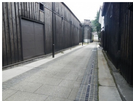
写真 6-7 石畳風舗装の事例① (長岡市摂田屋地区)
