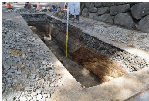
写真 5-15 2 トレンチ（南北）完掘（南西から）
