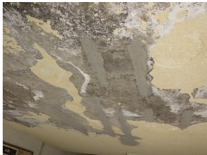
臨機応変な対応(補修工事における既存撤去時の天井爆裂箇所処理等)
