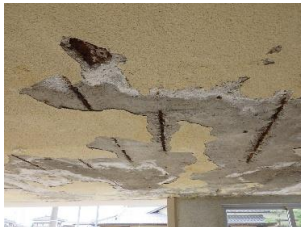
臨機応変な対応(補修工事における既存撤去時の天井爆裂箇所処理等)
