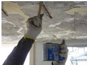
臨機応変な対応(補修工事における既存撤去時の天井爆裂箇所処理等)
