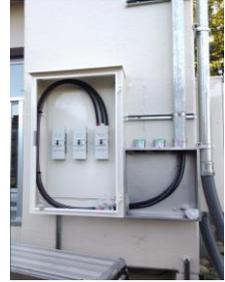
停電作業日前に既設盤(活線状態)を移設し、停電日に新設盤の取付・ケーブルの接続のみを行うことにより停電時間の短縮が行えた。
