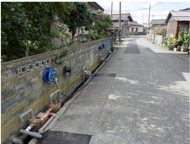
ジーメンスウェル工状況
