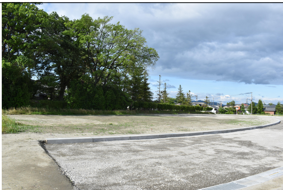
新市道の様子①（旧二の丸隅櫓側）
