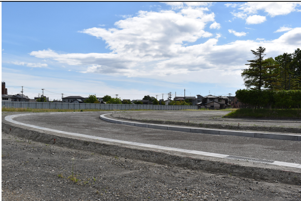
新市道の様子②（辰巳櫓側）
