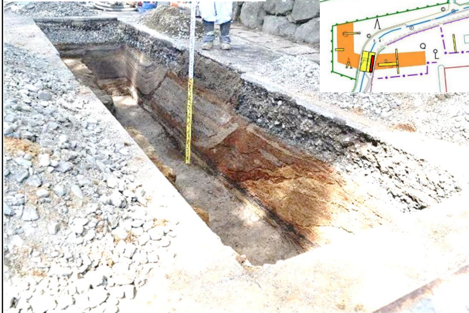
2トレンチ 土橋門推定箇所断面（南西から） ※令和6年度調査
