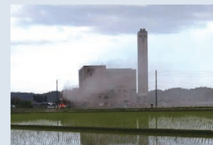
違反ごみが原因で火災になった 新発田広域クリーンセンター
