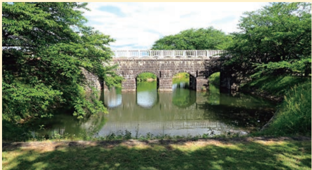
▶加治川分水門
