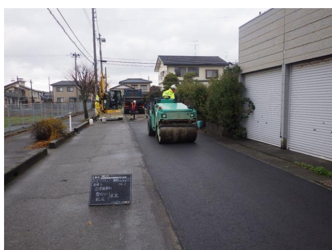
アスファルト舗設状況
