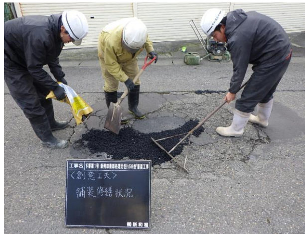
舗装劣化部の補修(地域貢献)
